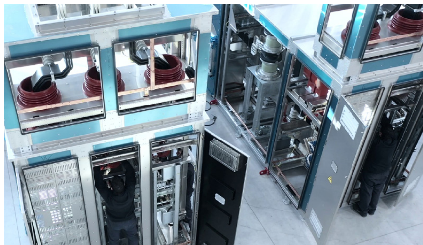
Fasi di assemblaggio e cablaggio dei quadri elettrici MT nello stabilimento Casagrande Elettrocostruzioni
