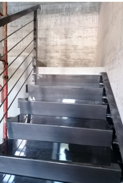
Scala con gradini pressopiegati con finitura lucida a vista
