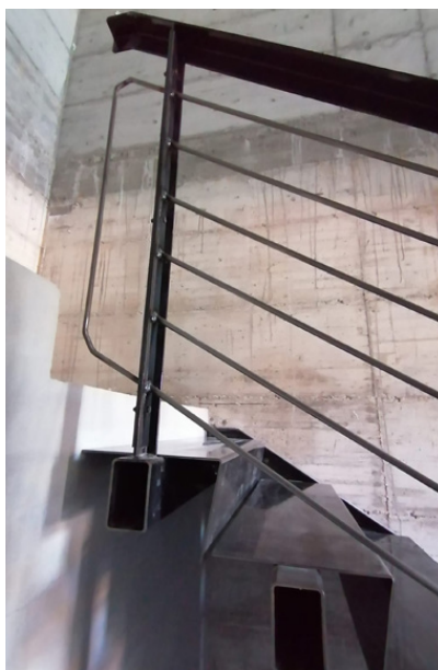
Scala con gradini pressopiegati con finitura lucida a vista
