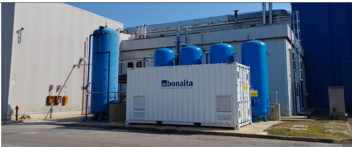
Dettaglio progettazione e impianto di generazione di azoto in container realizzato da Air Bonaita con prodotti Parker Hannifin
