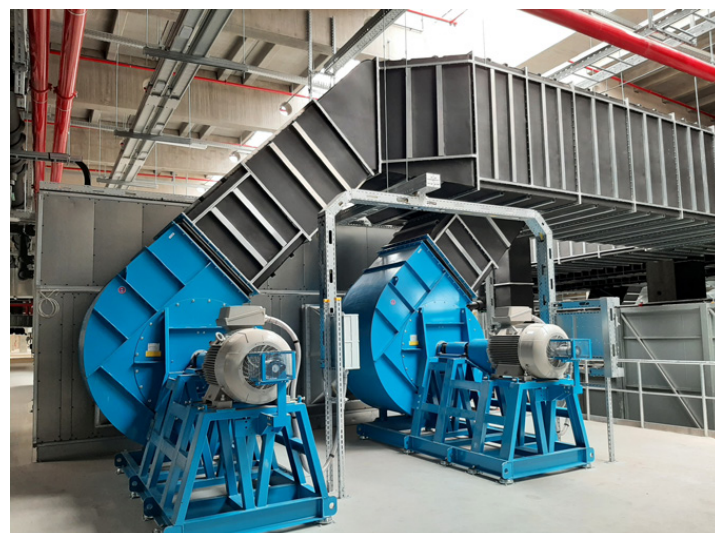
Esempio di installazione in fabbrica automotive di un ventilatore Comefri centrifugo industriale a singola aspirazione, girante con diametro 1.250 mm, motore ad accoppiamento diretto
