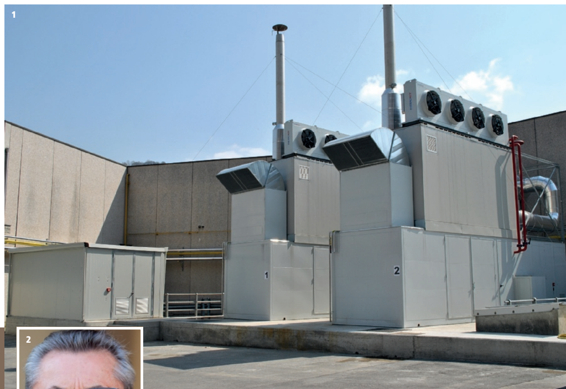
1. L'impianto di cogenerazione installato in Texcene produce simultaneamente energia elettrica e termica
