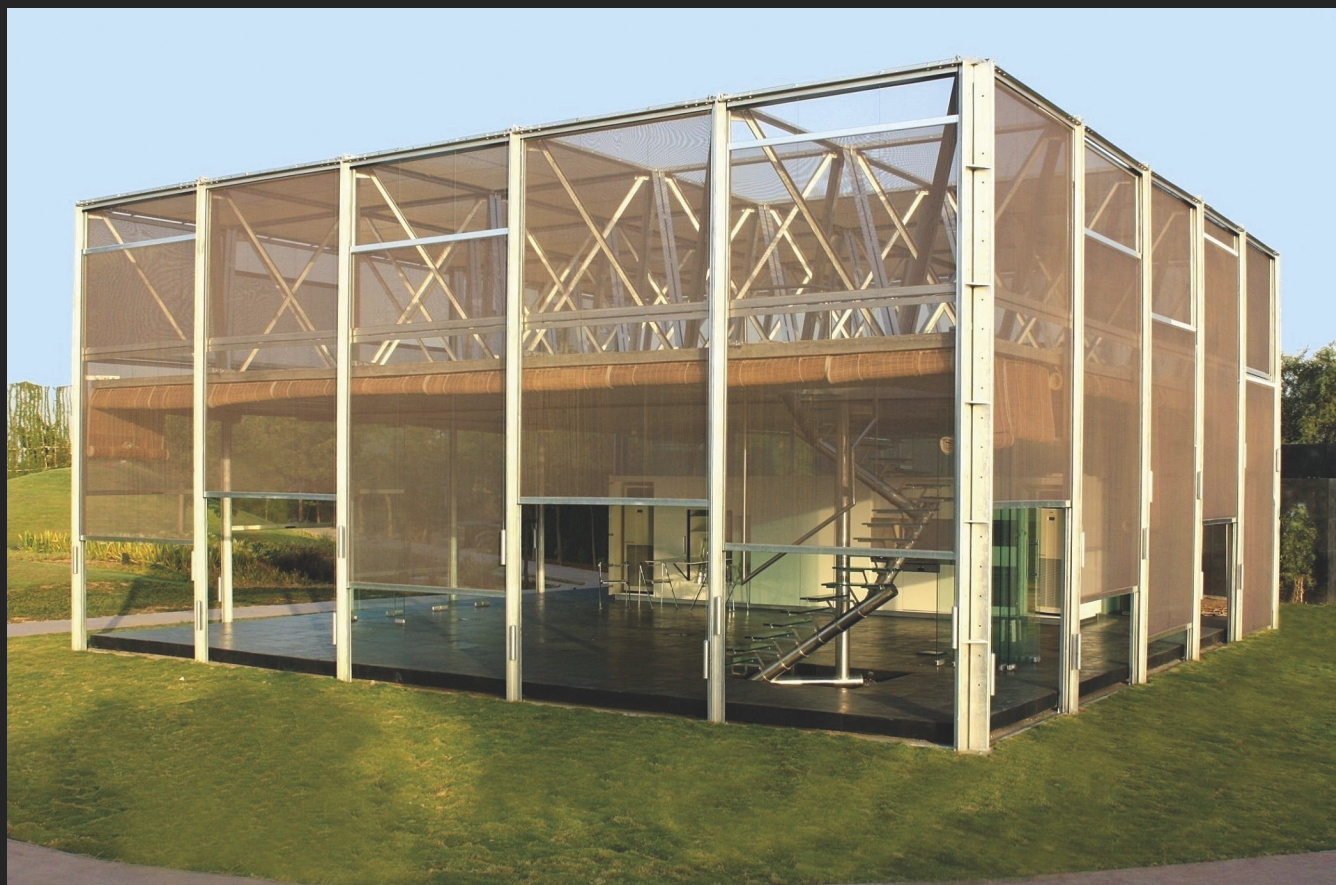
NET house, Matharoo associates, sistema di facciata e tamponamento in rete di nylon
