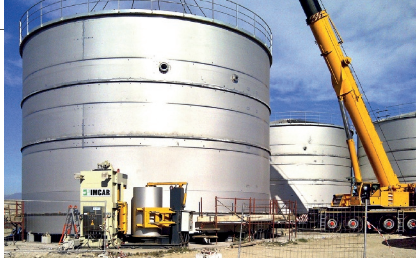
Dettaglio produzione di grandi serbatoi in cantiere
