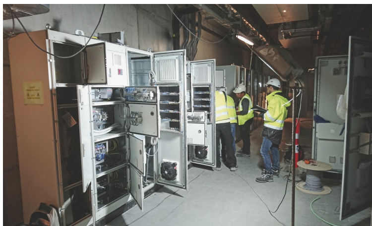
Quadri di comando EVS della stazione denominata "FBA" già installati al piano tecnico durante i collaudi, eseguiti congiuntamente da Systemair e H.S. Progetti.
