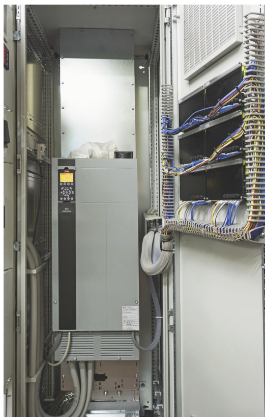
Inverter Danfoss Drives VLT® FC102 da 250 kW montato all'interno del suo cubicolo. Si notino il "back channel cooling" montato nella parte inferiore e superiore dell'inverter e la compattezza dell'inverter stesso.
